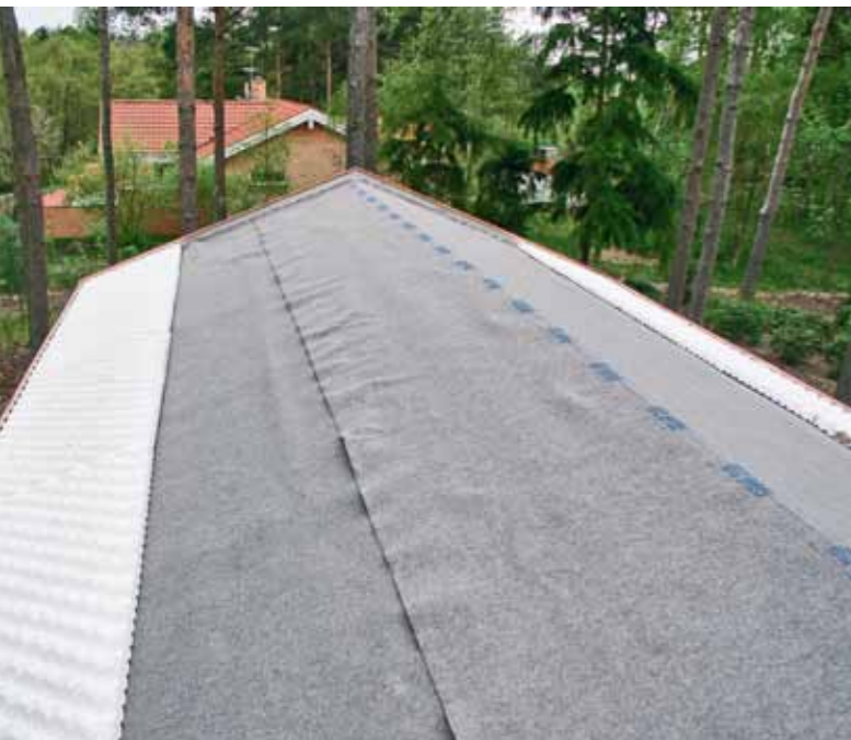
Før plantningsarbejdet gik i gang, udlagde gartnerne et lag vandafledende filt på det eksisterende tagpap. "Æggebakkerne" af flamingo, som blev placeret ovenpå igen, sikrer, at der gemmes små lagre af vand til planterne.
