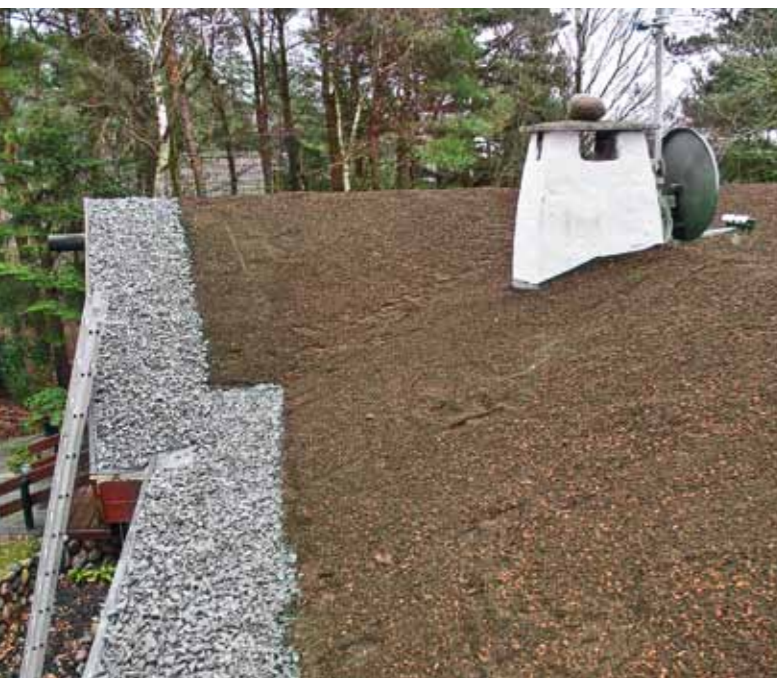
Før at hindre blomstertaget i at blæse væk har gartnerne udlagt en kant af granitskærver. Denne kant kan udelades, hvis man lægger præfabrikerede mos- Sedum -måtter ud.
