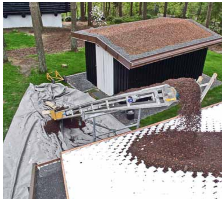
Vækstmediet er en blanding af kompost, tegl og leca, som egner sig til at opsuge regnvand, og som Sedum trives godt i.
